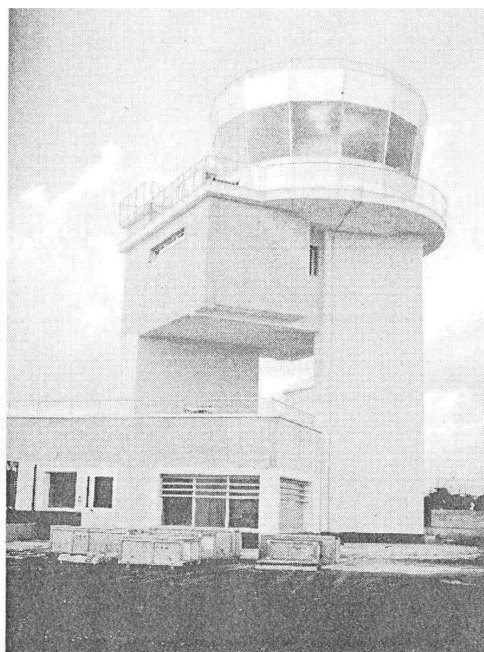
La torre di controllo dell'aeroporto «Magliocco»
